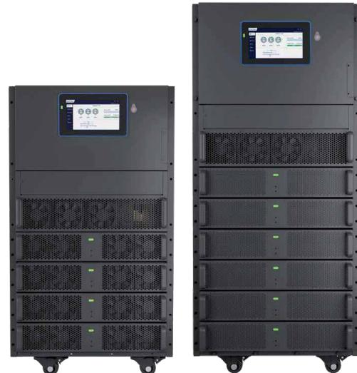
Серия ИБП МУЛЬТИПЛЕКС — это масштабируемая система, выполненная по технологии двойного преобразования, с возможностью горячей замены модулей. Мощность системы варьируется от 25 до 300 кВА/кВт, что делает ее идеальным выбором для современного data-центра. В силовых модулях используется новейшая трехуровневая IGBT-технология и технология полного DSP контроля, что делает систему МУЛЬТИПЛЕКС лучшей комбинацией надежности и гибкости.
